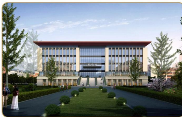
▲ 新校区综合楼
